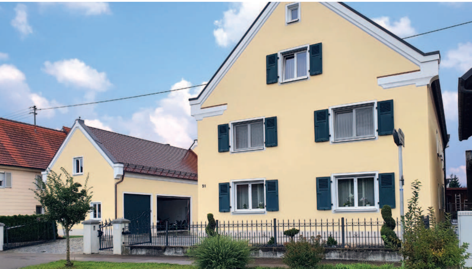
Regionaltypische, renovierte Hofstelle im Ortskern von Schweningen
